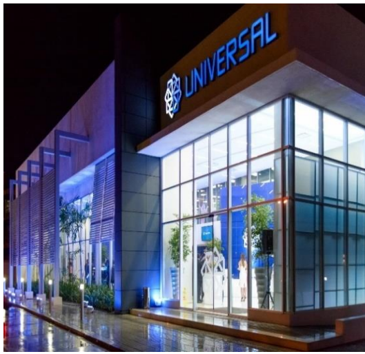
Edificio Universal Zona Oriental
