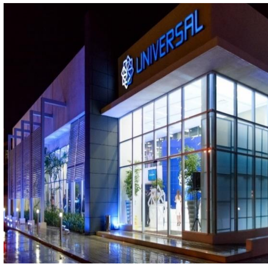
Edificio Universal Zona Oriental
