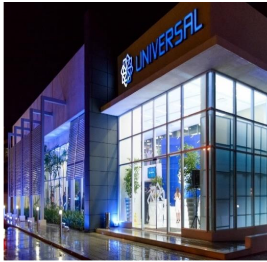
Edificio Universal Zona Oriental
