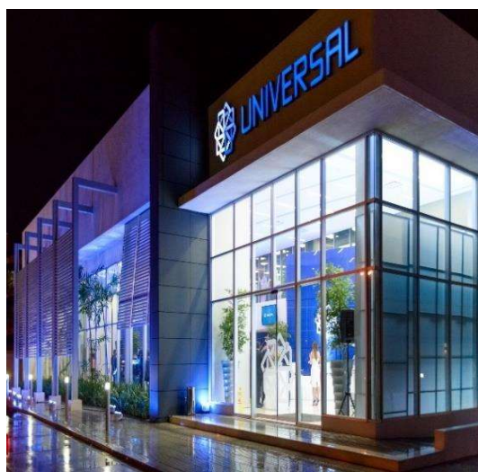
Edificio Universal Zona Oriental
